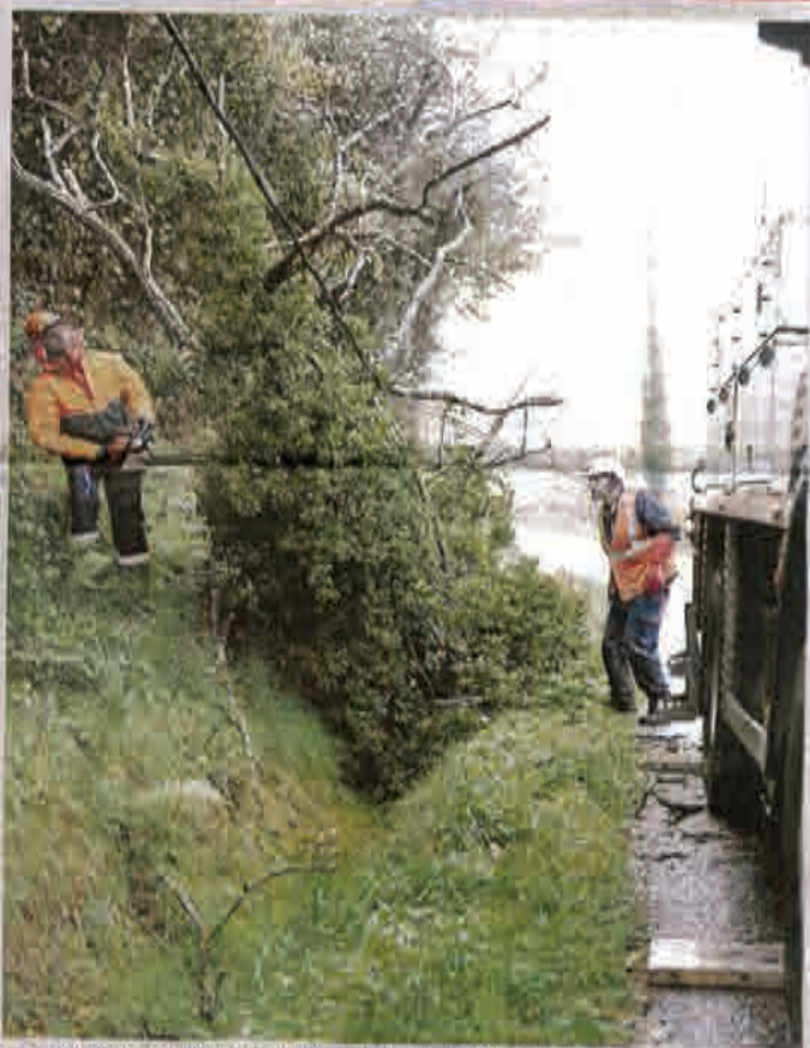
Plus de 200 lignes privées d'électricité devaient être raccordées au réseau. / Photo Sophie Lemaire
