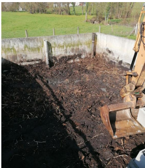
Curage des lits de la step d'Arcizac
