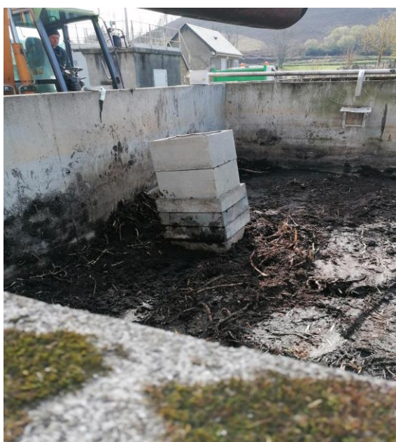
Mise en place de réhausses sur les cheminées
